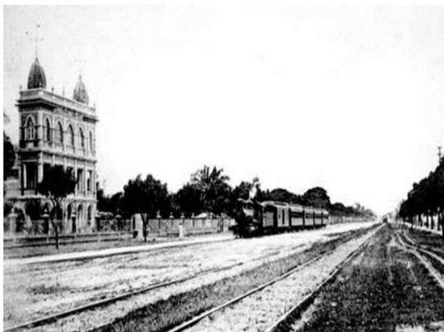
Figura 19: Avenida Tito Franco, atualmente Almirante Barroso, compondo o principal eixo de escoamento da Borracha no século XX.
