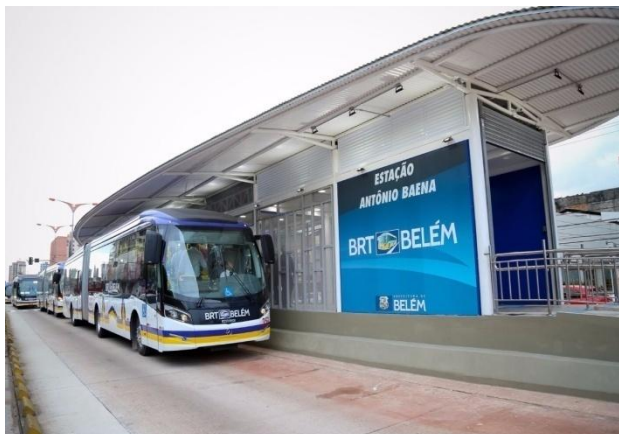
Figura 55: BRT estacionado na estação da Julio César em funcionamento. A concepção do BRT é proporcionar aos usuários um deslocamento rápido, seguro e confortável.
